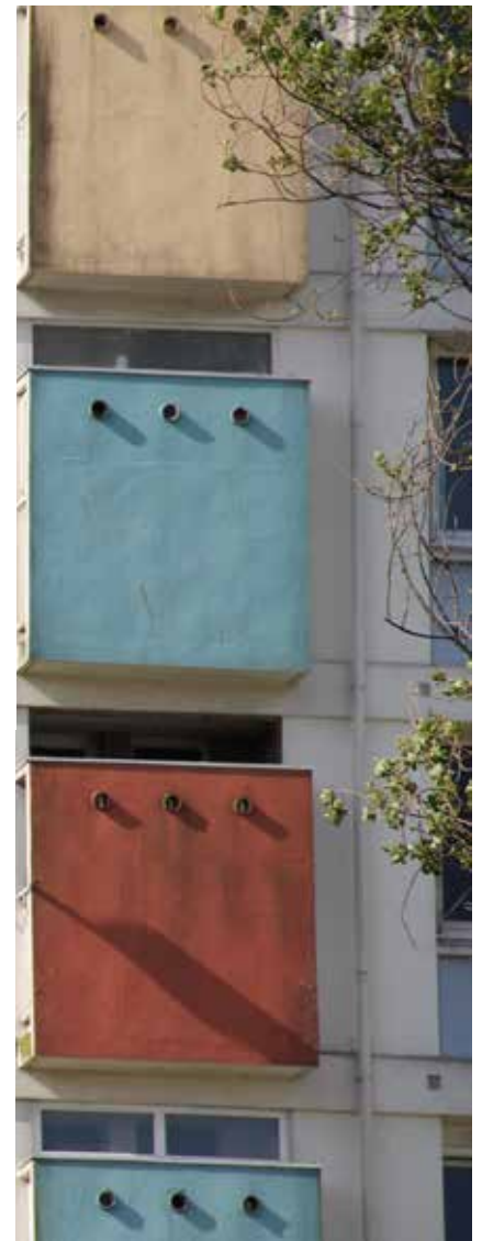
Photo : Barre Rue du Dourjacq - Brest - ADEUPa
