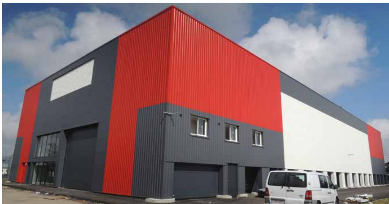
Entrepôts de Locabox (Kergaradec) - Gouesnou © Arnaud Jaouen
