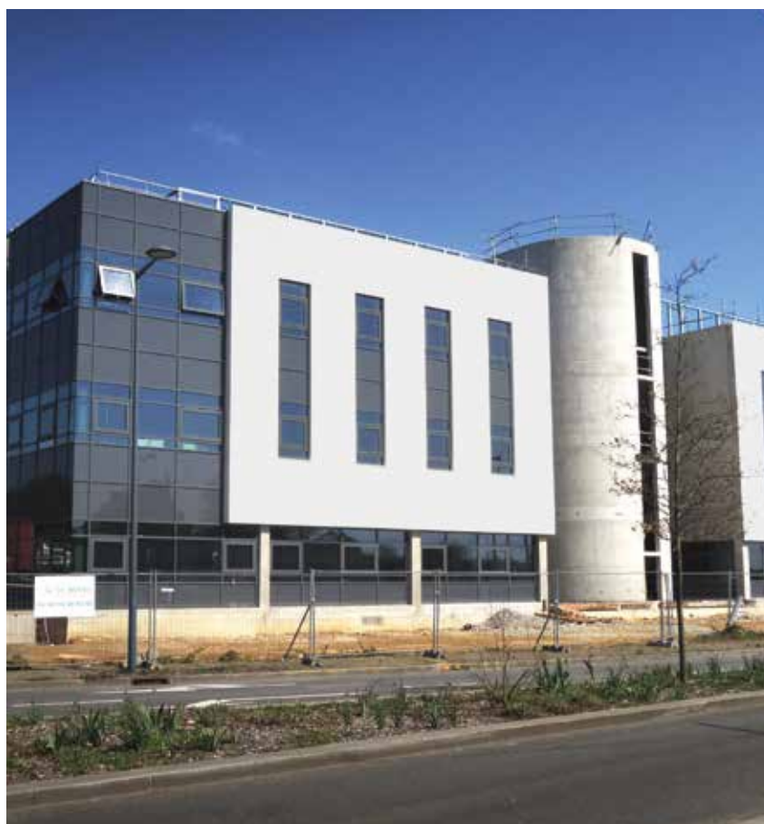
Construction de bureaux pour DCNS (Kerlaurent - Gulpivas) © Arnaud Jacouen
