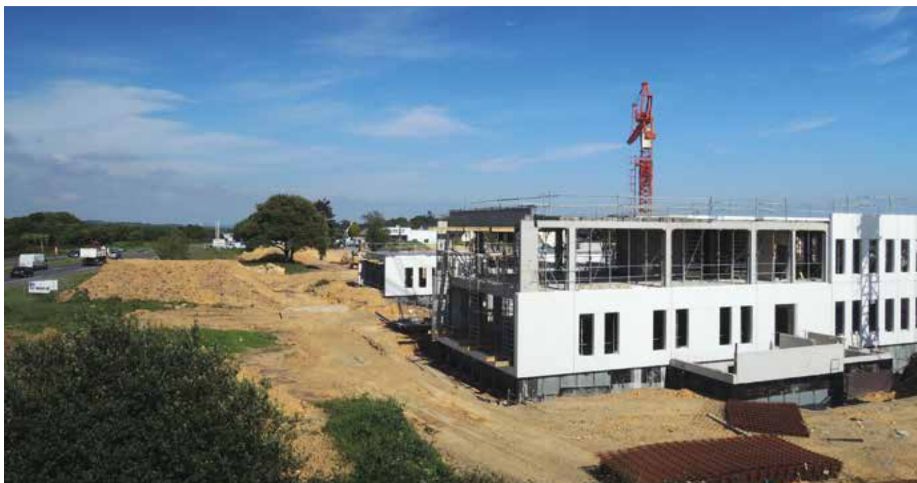
Construction du siège social de Savéol (Plougastel-Daoulas) © Arnaud Jacouen
