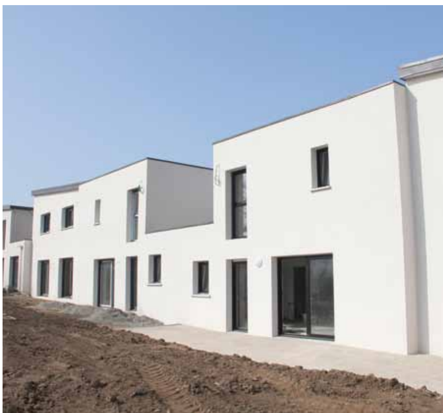
Programme neuf en lotissement à Plabennec - Crédit photo: ADEUPa
