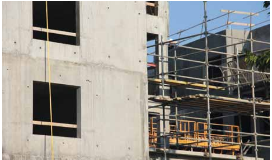
Construction logements collectifs à Brest - Crédit photos : ADEUPa
