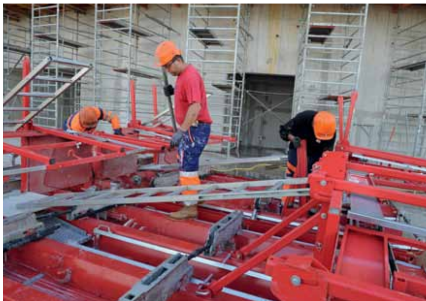
Construction de la grande salle de spectacles sportifs et événementiels à Brest. Crédit photo : Dominique Leroux
