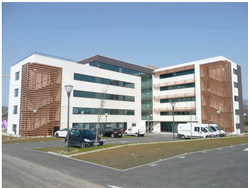
Immeuble de bureaux à Prat-Pip
