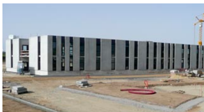
Immeuble de bureaux à Prat-Pip
