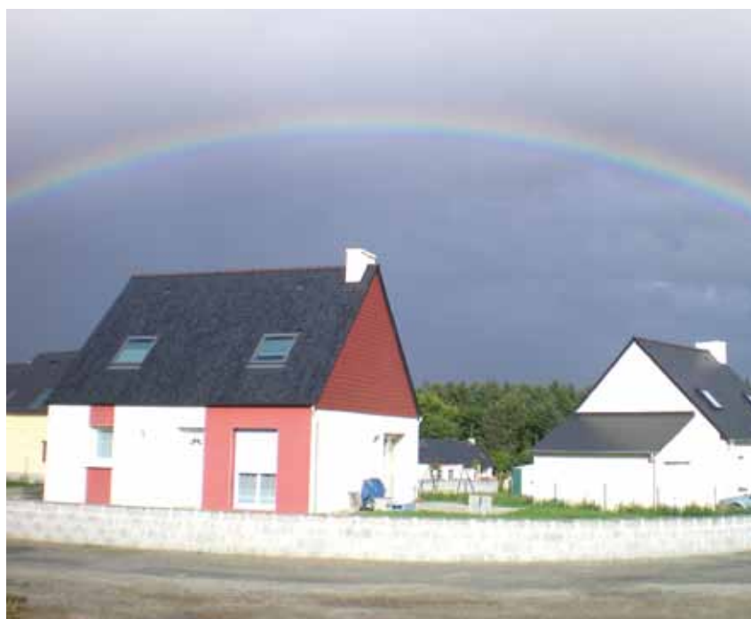
Lotissement neuf à Pont de Buis - Crédit photo: ADEUPa
