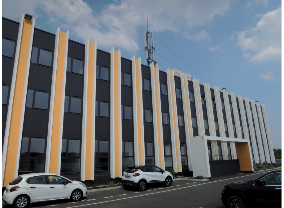
Immeuble de bureaux (Kergonan Nord - Brest)
