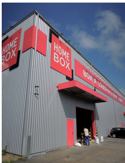
Entrepôts pour la société Homebox (Kergonan Nord - Brest)
