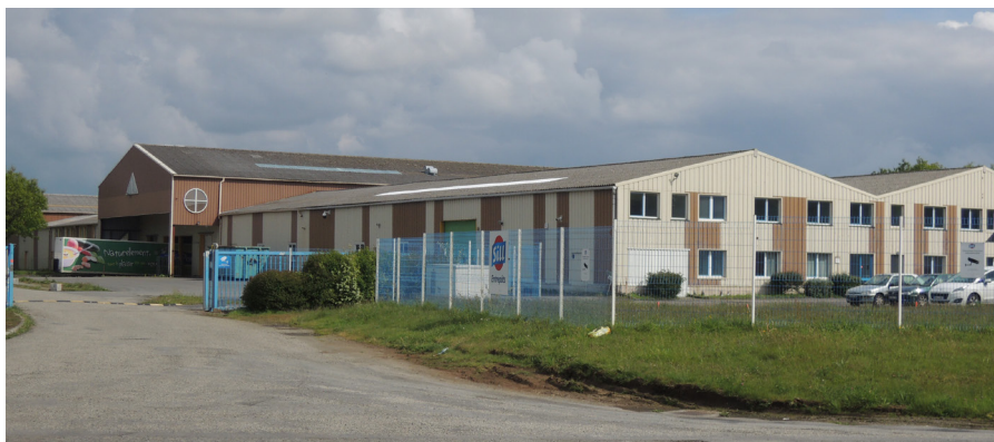
Entrepôts de la Sill (Le Drennec)
