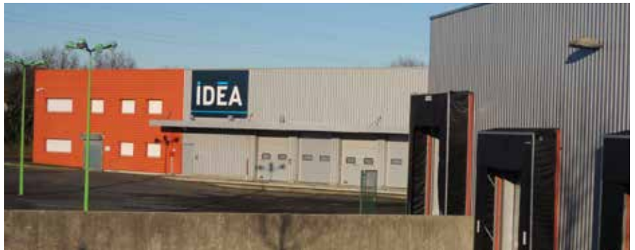
Entrepôt logistique pour Idéa (Lavallot, Guipavas)
