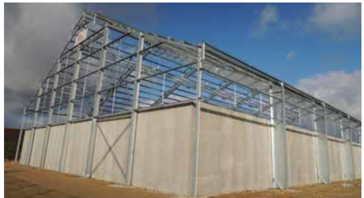
Local de séchage de céréales pour SAS Le Gall-Corre (Mescoden Est, Ploudaniel)
