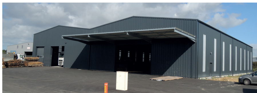
Entrepôts supplémentaires pour Elicas Métal (Penhoat, Plabennec)
