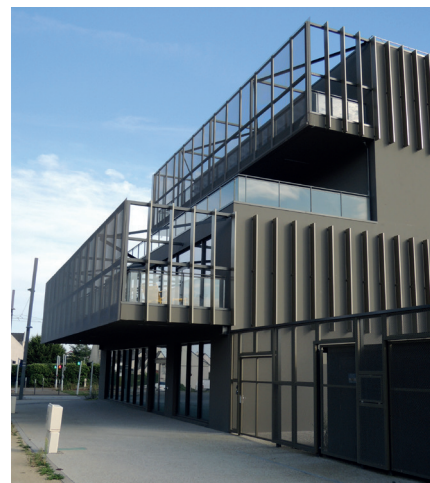
Bureaux pour OVH (Hermitage II, Brest)
