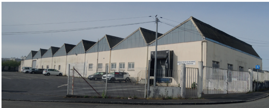
Futur site du centre de formation technique Cefortech (Kergonan Sud, Brest)
