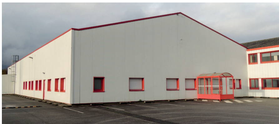
Entrepôts anciens en location (3 000 m 2 ), zone de Stang ar Garront (Châteaulin)
