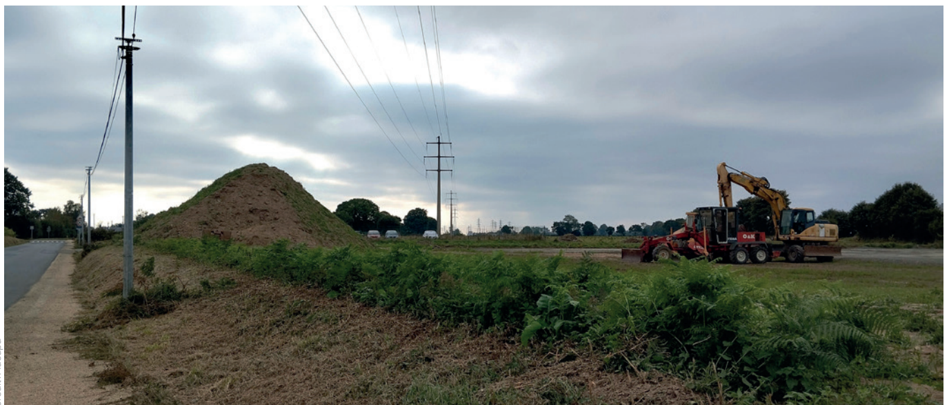
Travaux route de Buhulien à Rospez
