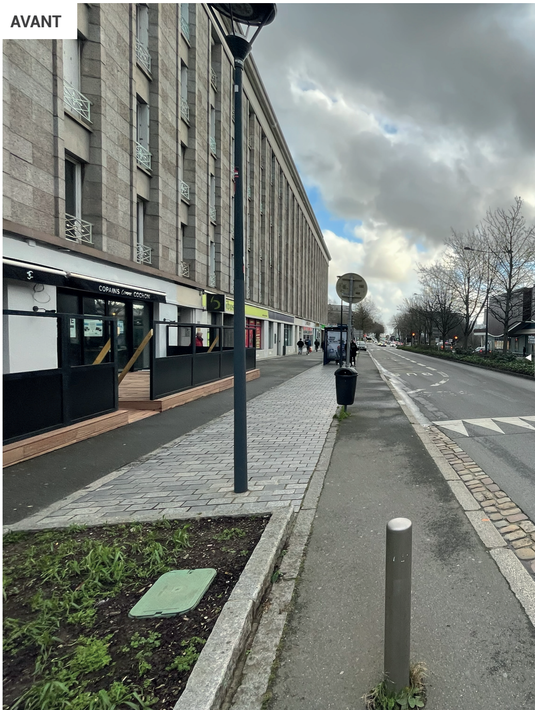
Photos prises avenue Clémenceau à Brest, avant (le 9/01/2023) et après (9/06/2026) les travaux de la nouvelle ligne de tramway
