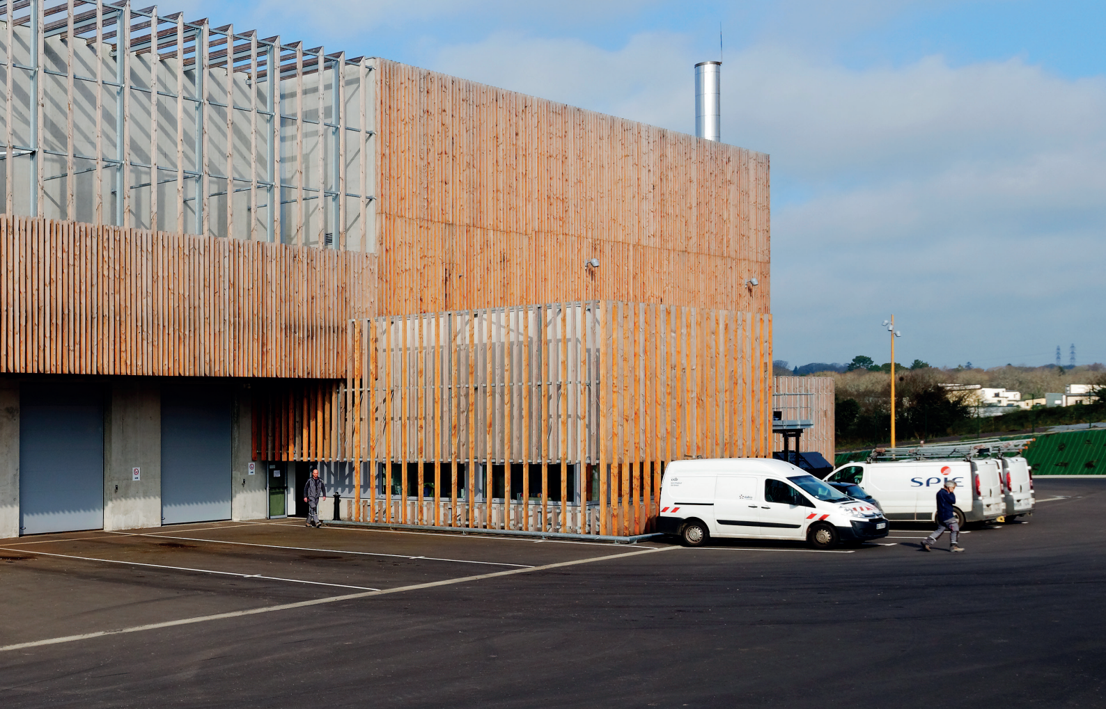
Chaudière bois du Spenot - Photo: Guillaume Team - Brest métropole
