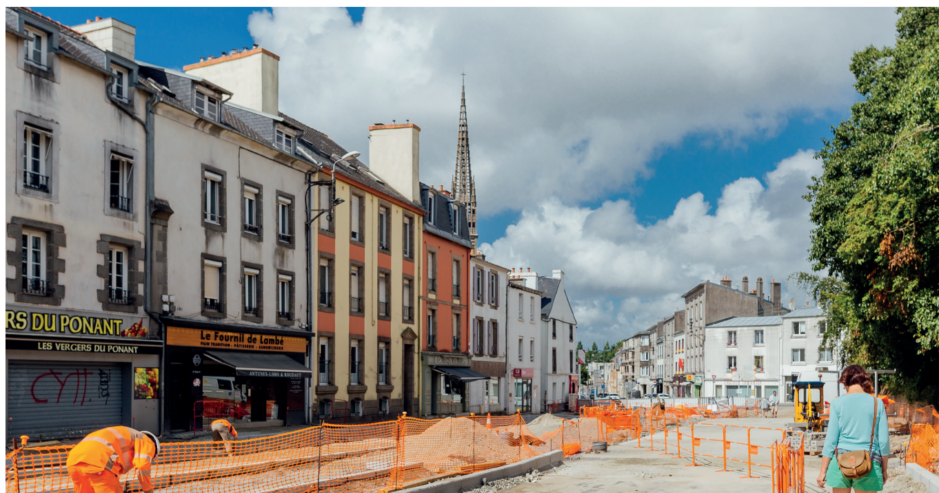
Travaux à Lambézellec pour la future station BHNS - Crédit : Nacer Hammoui - Brest métropole
