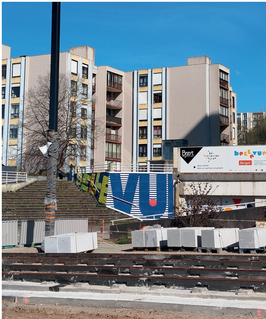
Travaux de la ligne de tramway dans le quartier de Bellevue, Brest - Crédit : Adeupa
