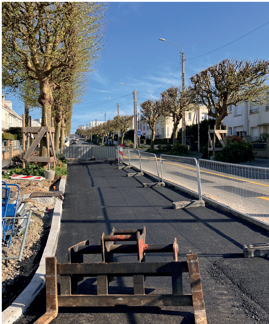
Travaux du BHNS à Lambézellec, Brest - Crédit : Adeupa
