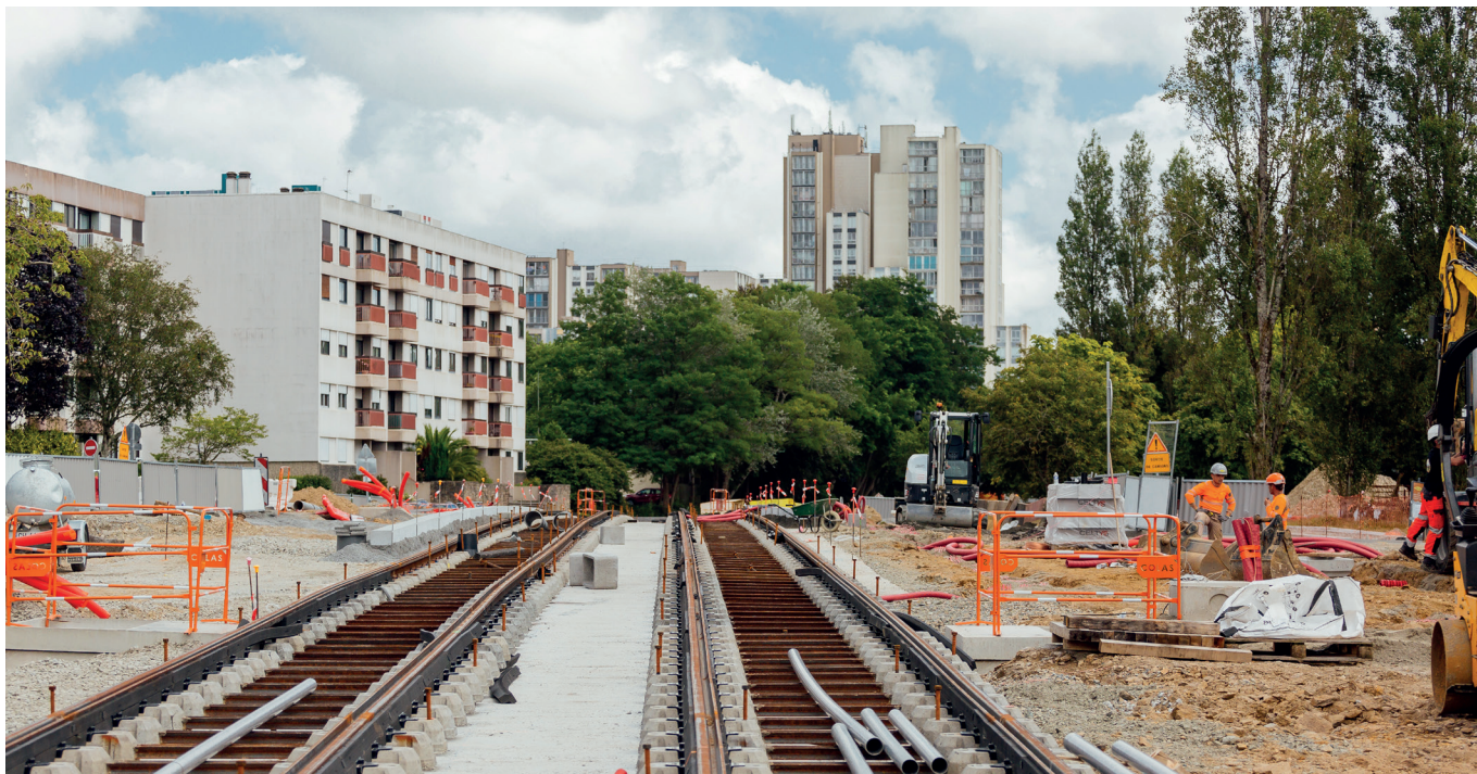
Travaux de la ligne de tramway dans le quartier de Bellevue, Brest - Crédit : Nacer Hammoui - Brest métropole
