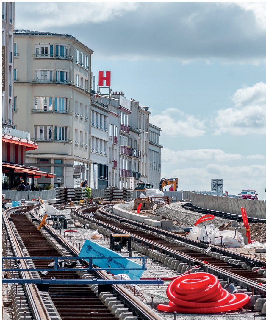
Travaux de la ligne de tramway avenue Georges Clémenceau, Brest - Crédit : Damien Goret – Brest métropole
