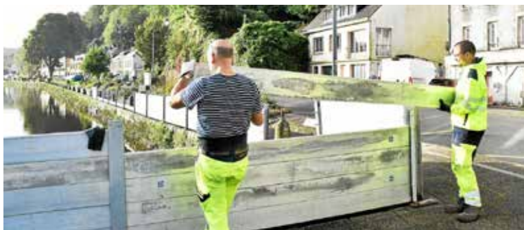
Solution semi-amovible : des barrières anti-inondations sont installées | Quimperlé (29), le long de la Laïta
