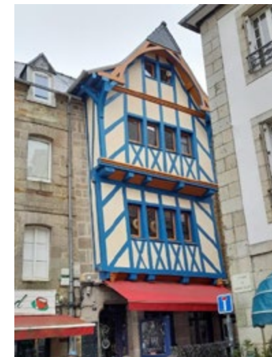
Restauration d'une façade à pans de bois | 7, place Général Leclerc, Lannion OPAH-RU / Campagne de ravalement obligatoire
