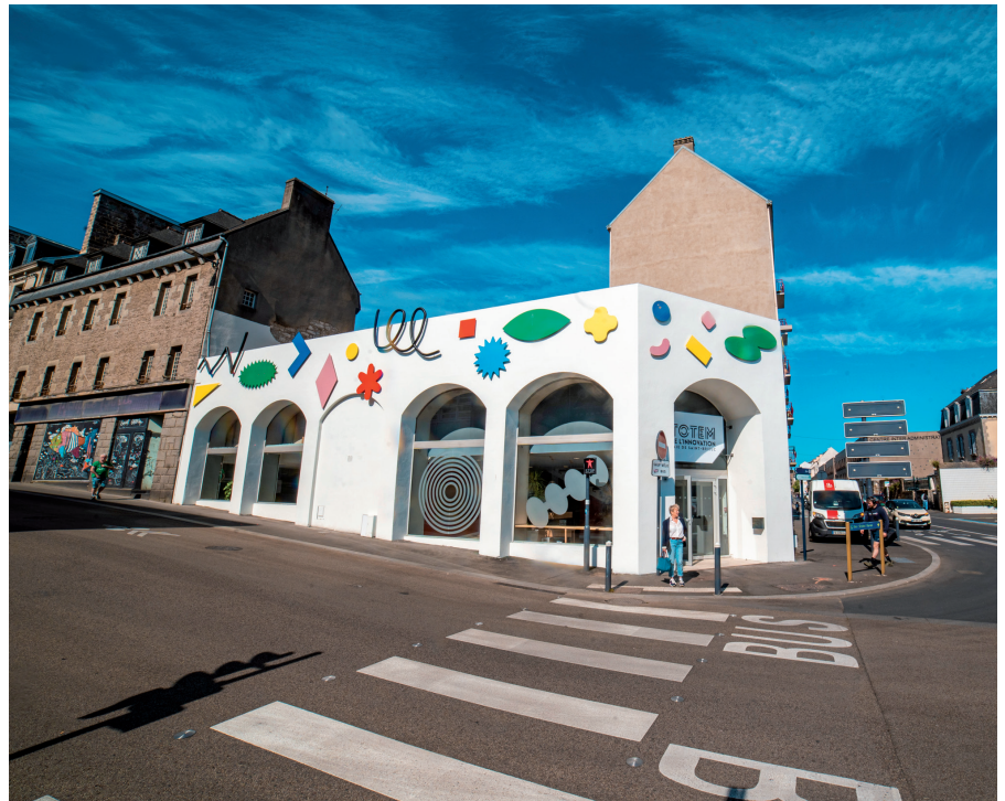
Bâtiment totem de l'innovation en centre-ville de Saint-Brieuc Photo : Boldry Production
