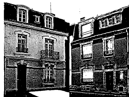
5-7 rue de-la-République, A. Freyssinet, 1909 et 1913
