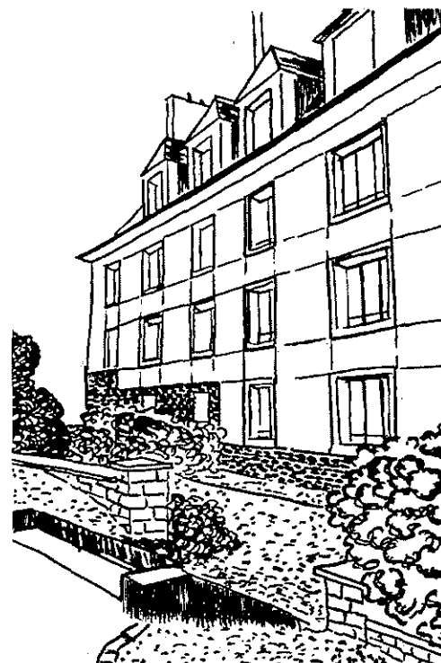
14 rue de-Messidou, façade sur le square
