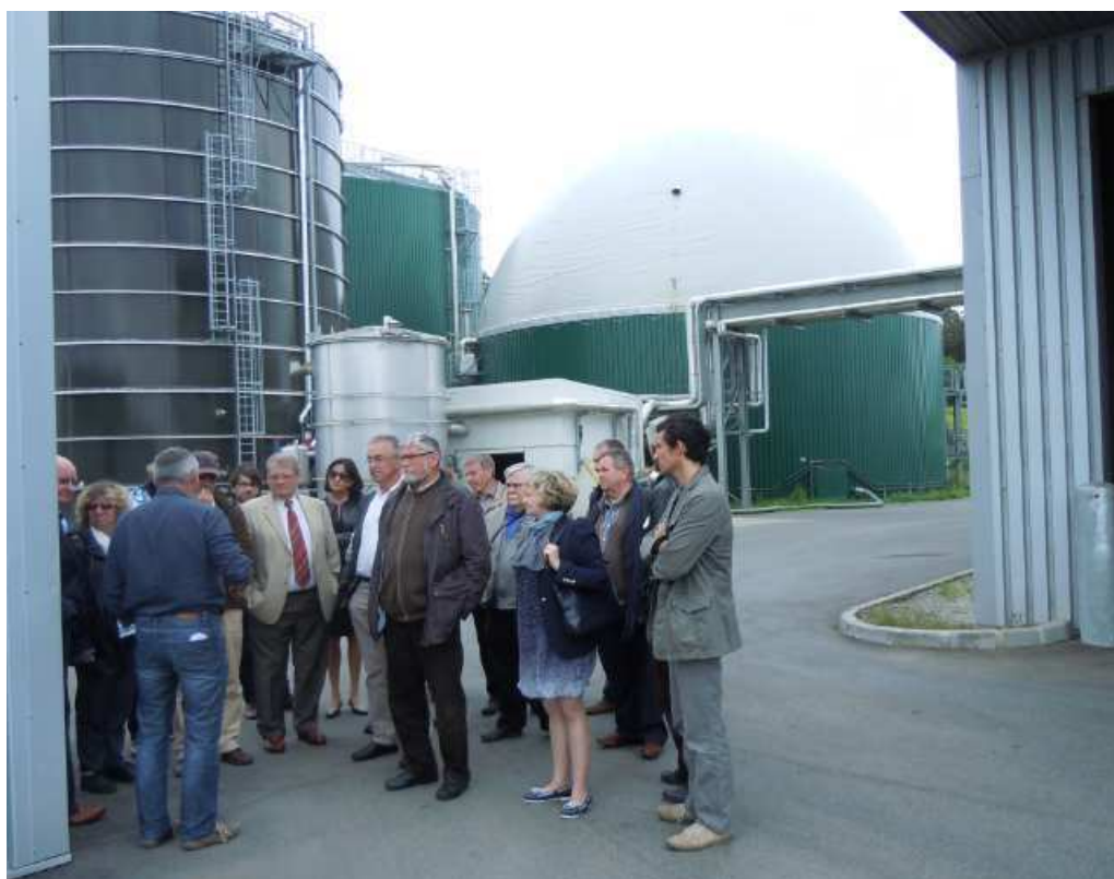
Figure 106. Unité de méthanisation de Géotexia
