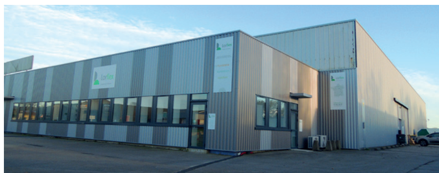
Lorflex investit un bâtiment remis à la page (Kergaradec, Guipavas)
